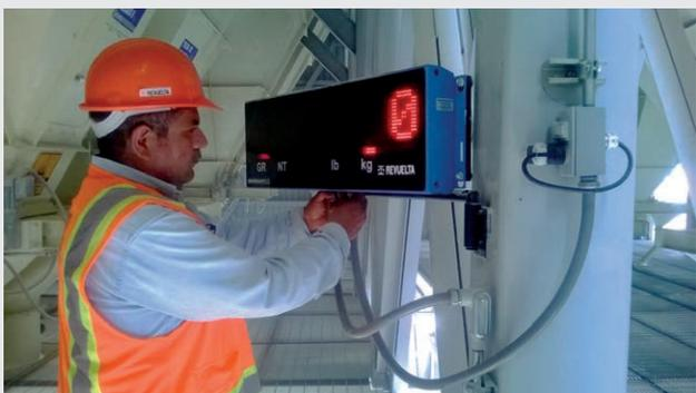
El Sistema de Pantallas Remotas nos ayuda a mantener la comunicación entre el pesador y el chofer del vehículo durante la pesada, agilizando los tiempos.
